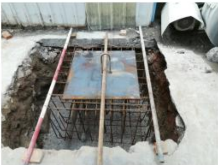
1.1 管道基础钢筋笼
